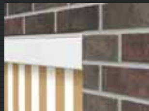
Fijación entre paredes caja cuadrada
